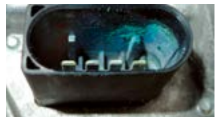
Einbaustecker mit Korrosionsspuren
