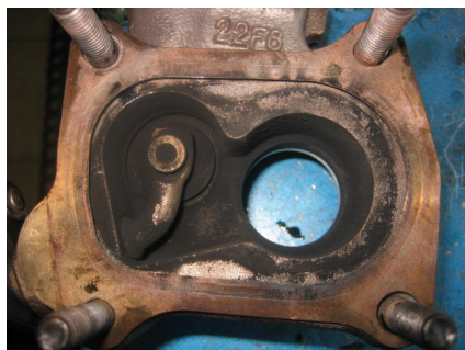
Megfelelően felszerelt tömítés
